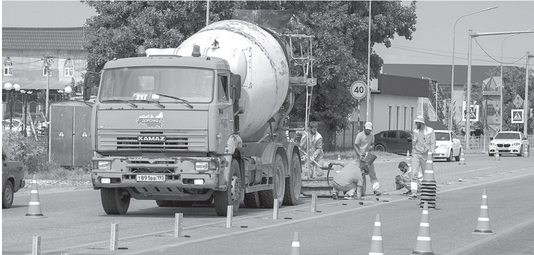
Продолжается капитальный ремонт участка федеральной трассы на подъезде к Черкесску
